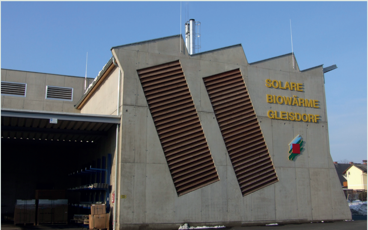
Fotos: Stadtwerke Gleisdorf, Ing. Karl Hierzer
